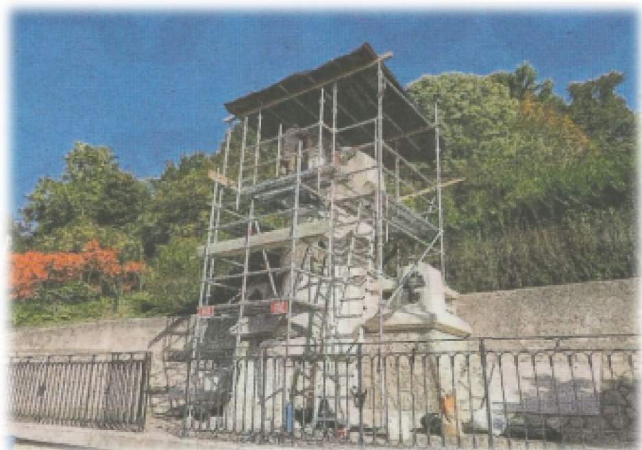
Monument en restauration
