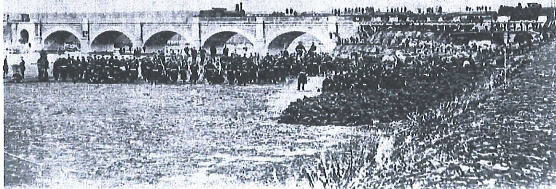
Le Pont sur la Moselle en état de reconstruction par les Allemands - Guerre 1870-71
